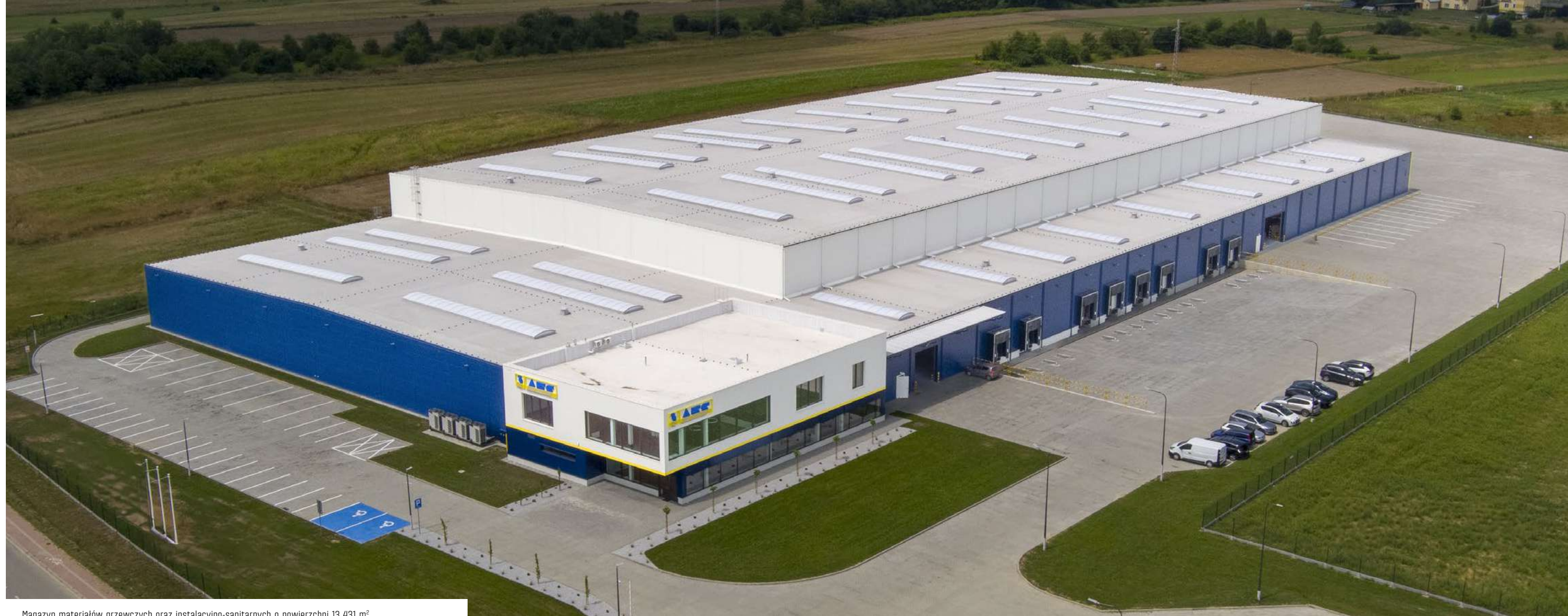
Magazyn materiałów grzewczych oraz instalacyjno-sanitarnych o powierzchni 13 431 m 2
