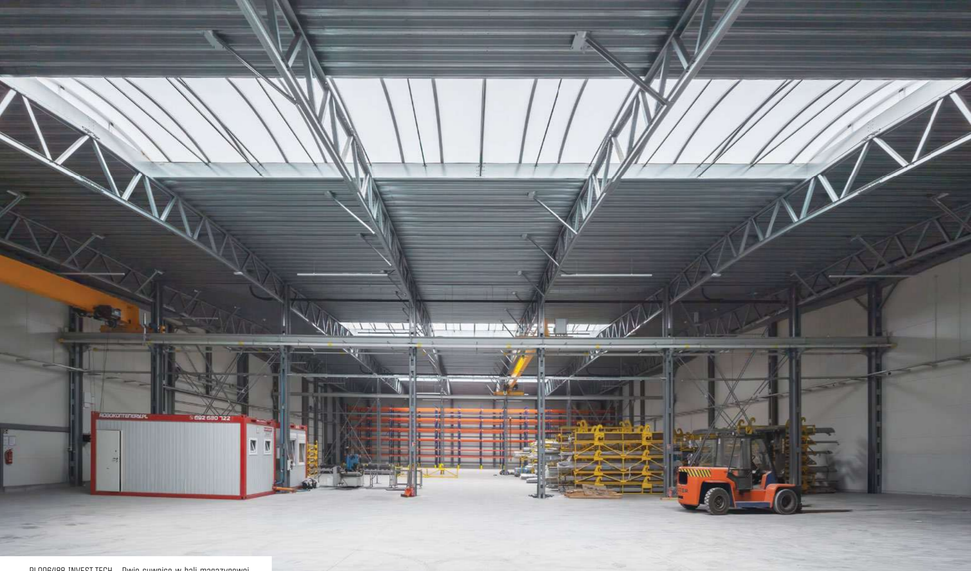
PL006488 INVEST-TECH – Dwie suwnice w hali magazynowej
