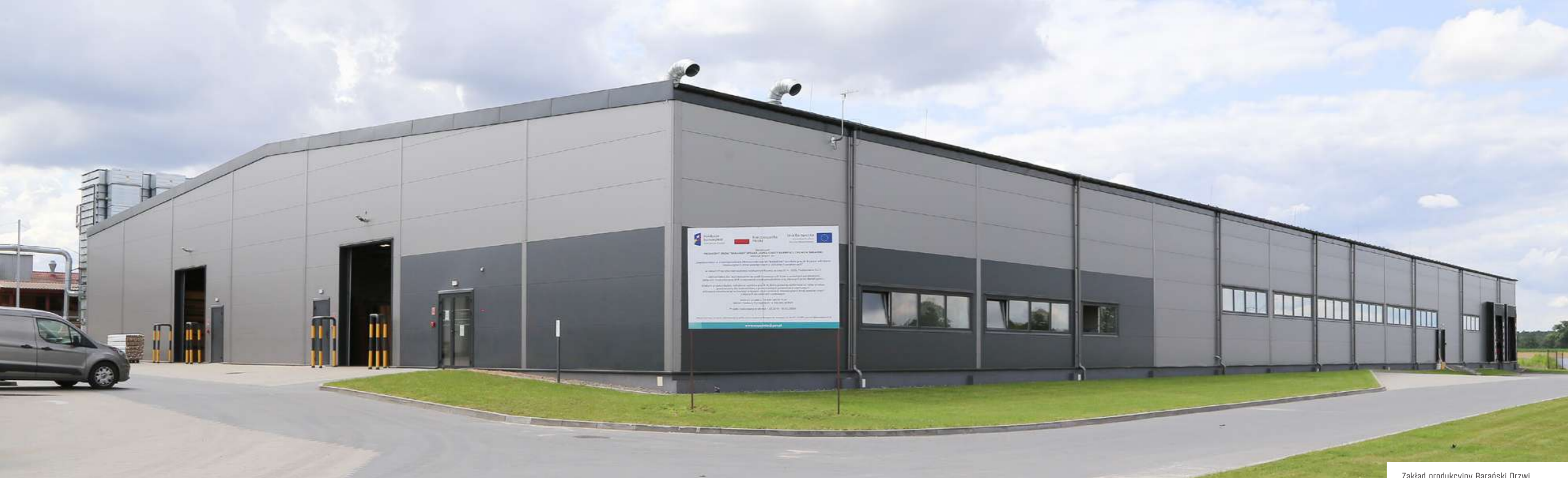
Zakład produkcyjny Barański Drzwi
